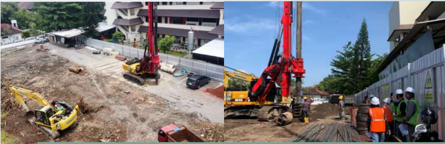
Proses Pembangunan Gedung LRT
